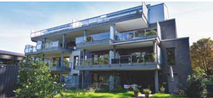
Wohnhaus Voerder Straße, Dinslaken, NRW Bauzeit: 11 Monate
