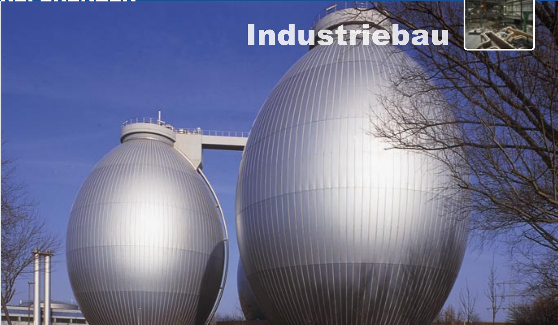
Oben: Faultürme Emschergenossenschaft Dinslaken
